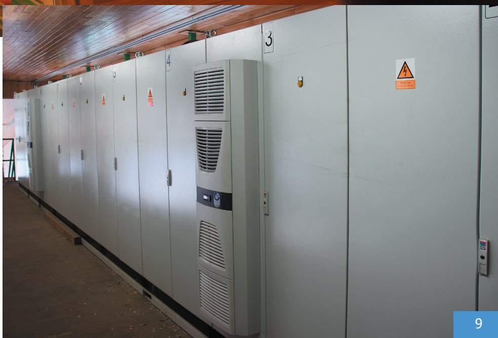
Obr. 12: Rozvaděče s elektroinstalací pily zabírají úctyhodný prostor
